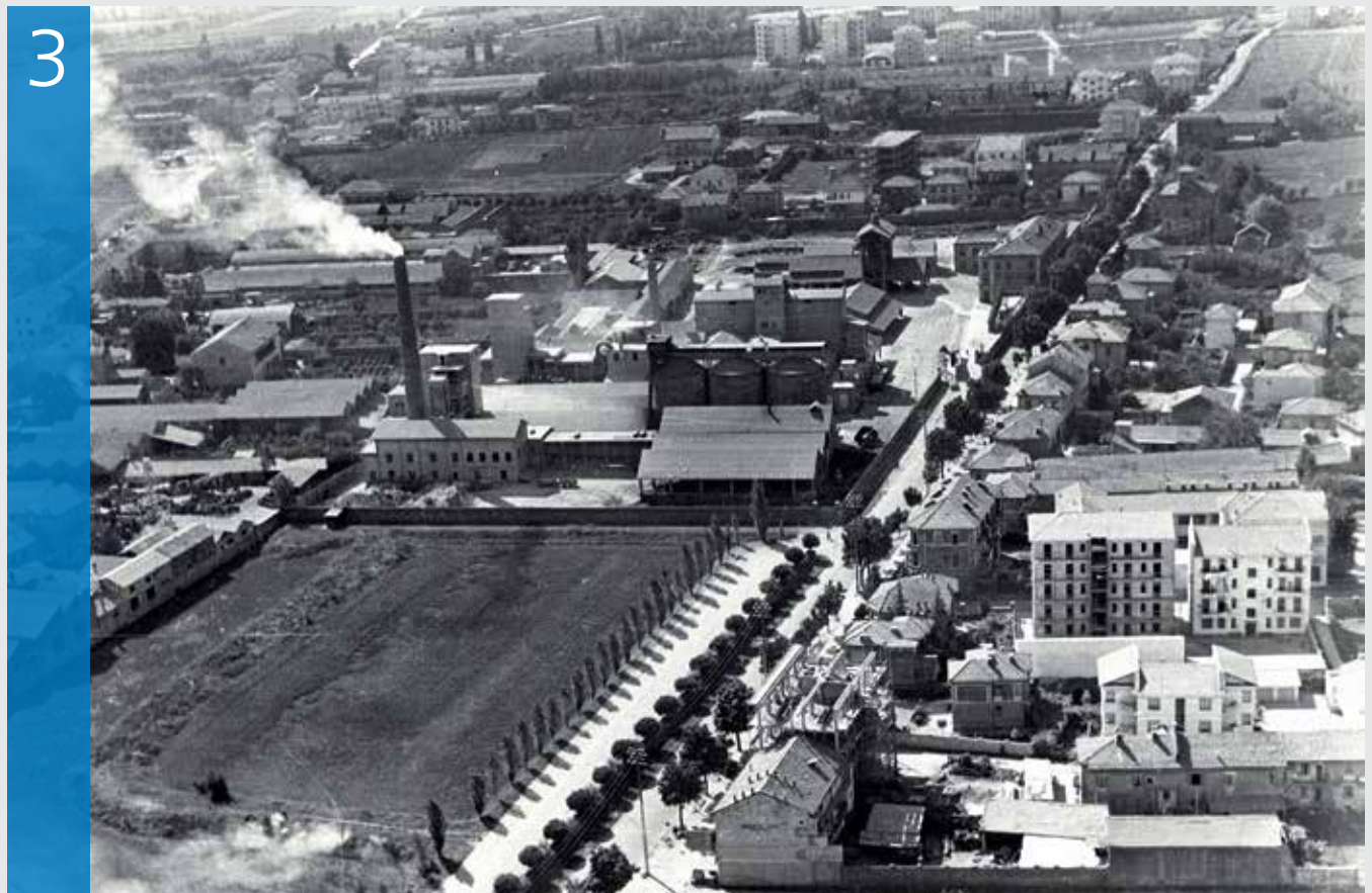
3. LO STABILIMENTO MARCHINO IN VIALE MARCHINO THE MARCHINO PLANT IN VIALE MARCHINO
